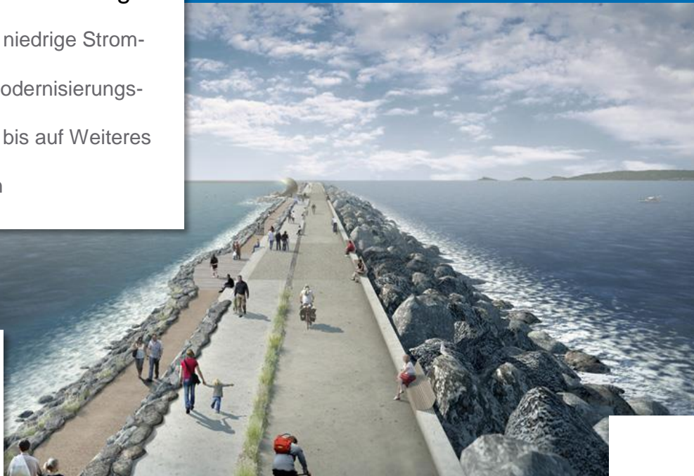
▲ Das Gezeitenlagunen-Wasserkraftwerk in der Swansea-Bucht, Wales, wird eine Gesamtleistung von 320 Megawatt haben.
